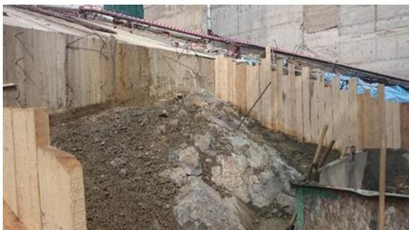
Рис. 5. Установленная опалубка на заключительном этапе очистки скалы
