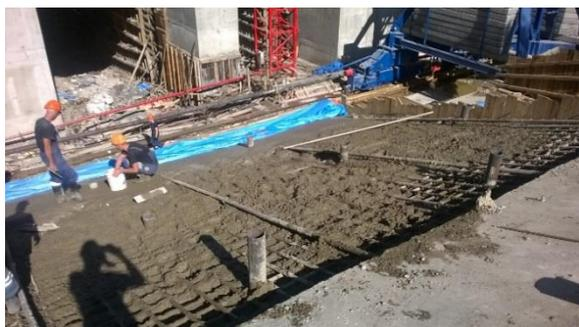
Рис. 8. Бетонирование блока. Процесс создания ровной поверхности
