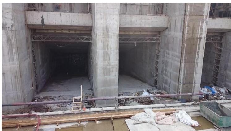
Рис. 2. Проходные отверстия блока агрегатов с генераторами
